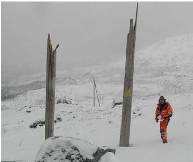
Fig. 3. Broken power line at Steigen, 25.01.2007. Photo: Nord-Salten kraftlag
